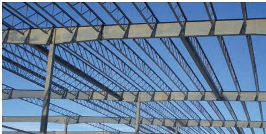
Le système à longue travée Long Bay® de Robertson est la solution tout indiquée pour optimiser l'espace intérieur. Novateur, ce produit de charpente de toit en acier sert à créer de vastes aires ouvertes au moyen de charpentes primaires à âme pleine et de pannes à âme ajourée préperforées (éléments de charpente secondaires du toit), ce qui permet de réaliser des travées d'une longueur maximale de 65 pieds (19,8 mètres).
